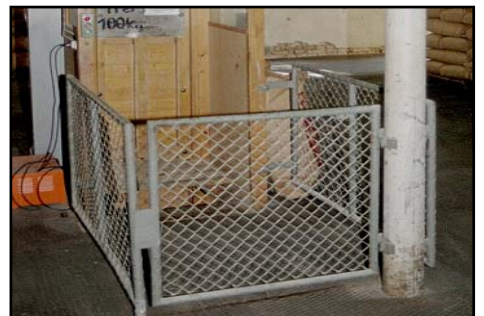
Bild 7: Sicherung einer Zutrittsöffnung im Bereich von Publikumsverkehr. (Genügend Platz zum Aussteigen vorsehen.)
