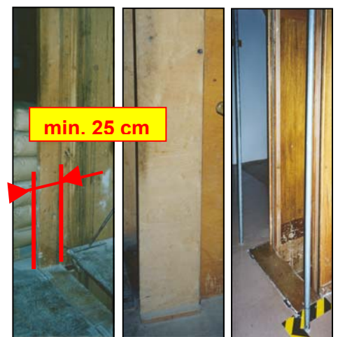
Bild 2 Bild 3 Bild 4 Bilder 3 und 4 zeigen, wie nicht-vorstehende Schachtwände mit Platten oder mit Stangen nachgerüstet werden können.
