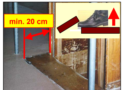
Bild 6: Die Bodenklappen verhindern ein Einklemmen von Körperteilen oder Waren.
